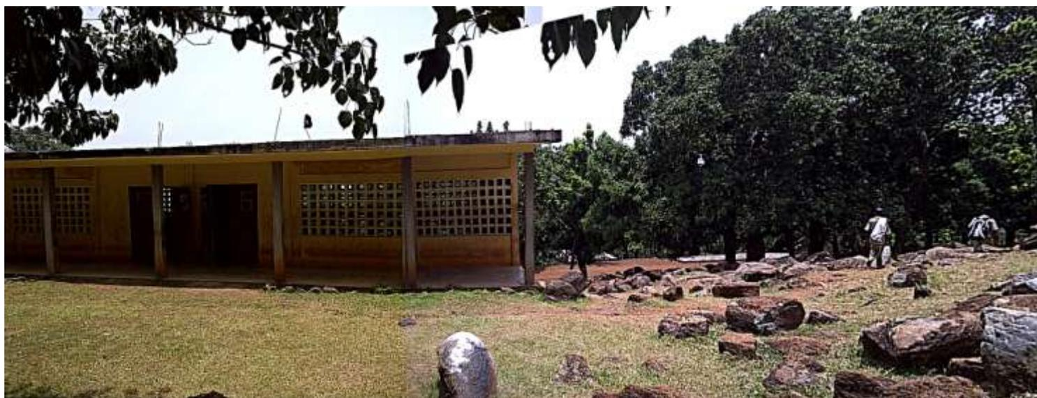
Le collège de Toe est une construction classique avec des salles de classe juxtaposées, ouvrant sur un couloir abrité. La toiture **n'a jamais été faite car on prévoyait de construire un étage. Il n'y a pas d'éclairage. L'amenée de canalisations d'eau et de sanitaire nécessitera de briser les rochers de basalte.**
